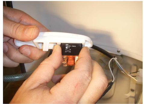
Retirer l'interrupteur en appuyant de chaque côté sur les clips
